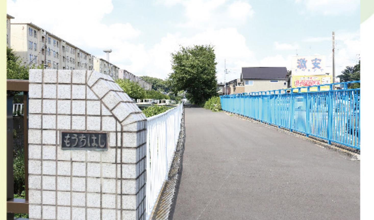
快適な遊歩道に整備されました
